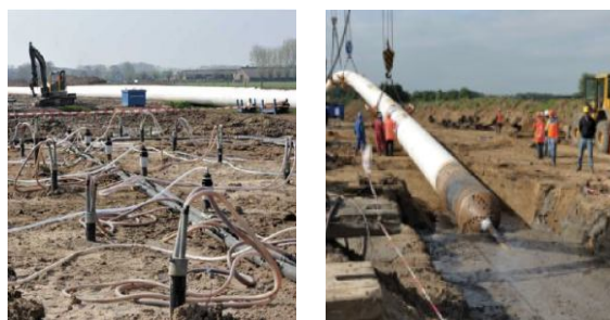
(a) 现场灌注井和抽取井布置 [24] (b) 现场铺设天然气管道 [25]
